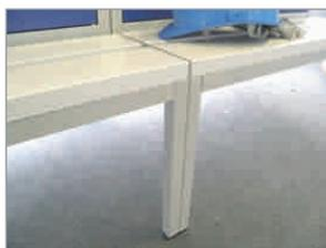
benachbarte Stützen ohne Zwischenraum, vorteilhaft zur Bodenreinigung
